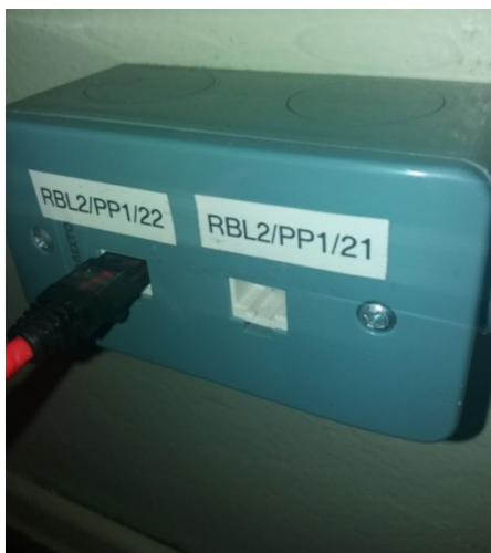
Fig. 5: Ponto de rede x2 devidamente identificado.
